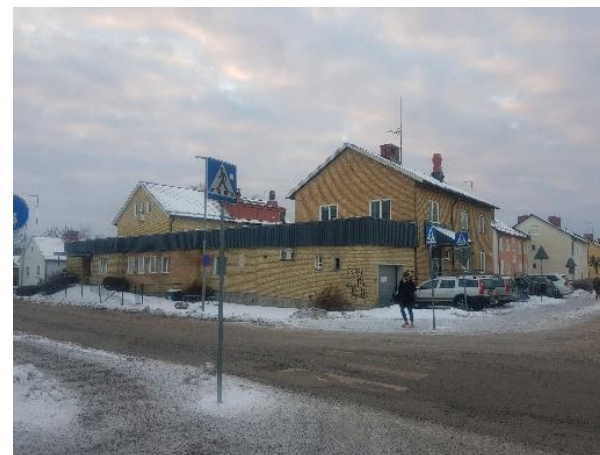
Gamla polishuset från korsningen Gärdesvägen/Allévägen Foto: Vallentuna kommun
