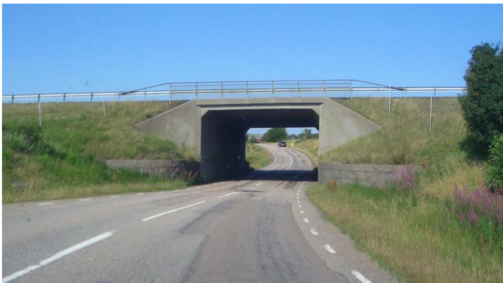
Referensbild på betongbro som kompletterats med stödmur i granit i anslutning till brostödet
