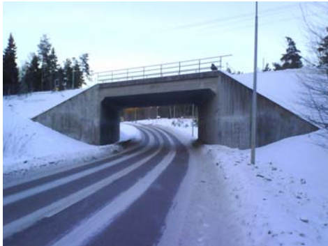
Korsning med Bällstabergsvägen
