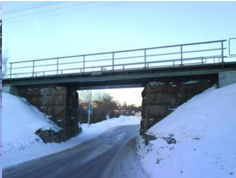
Korsning med Gamla Karlbergsvägen
