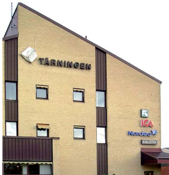
Välutformad grupperad skyltning med frilagda bokstäver på Tärningen.
