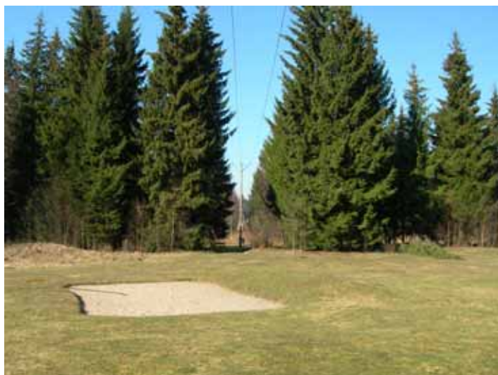
Luftledning som går i nord-sydlig riktning
