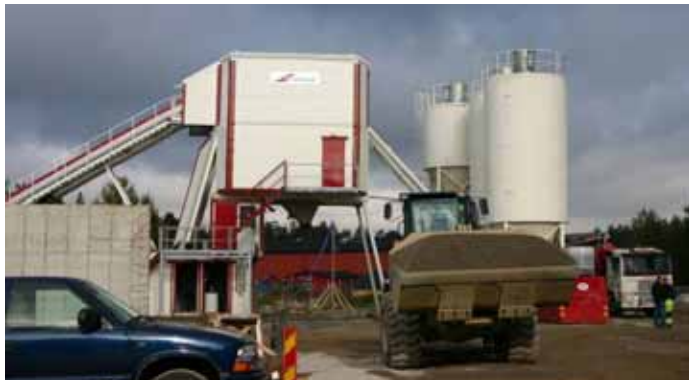
Bild över betongfabriken vid Okvista industriområde
