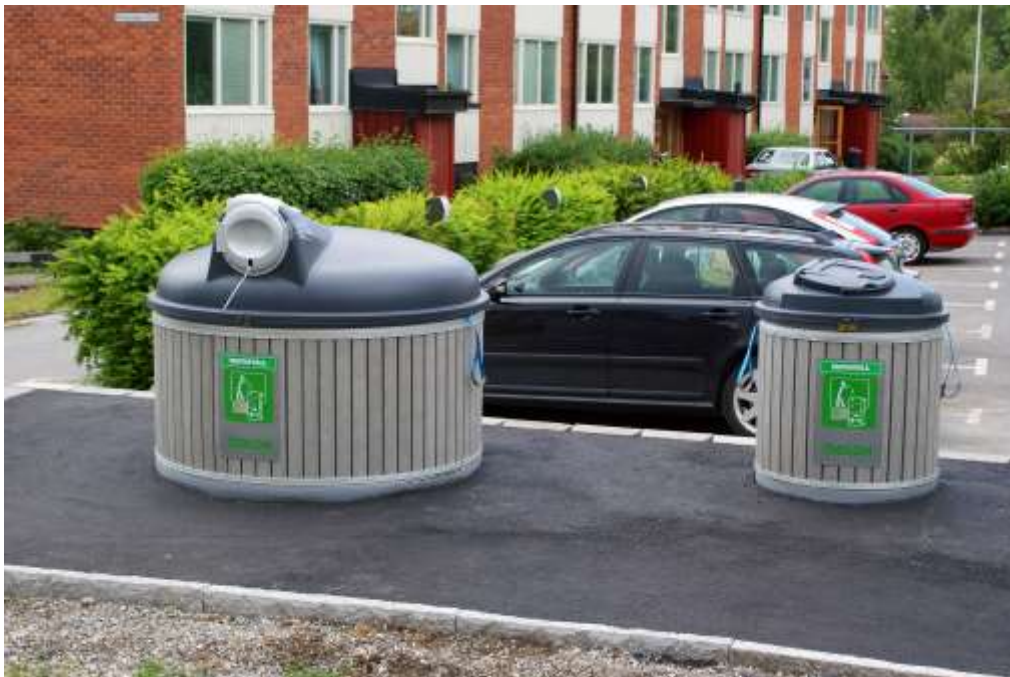
Underjordsbehållare för matavfall respektive brännbart hushållsavfall.
