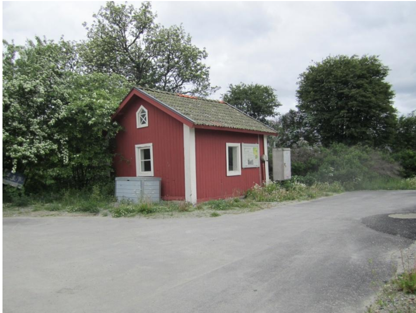
Östra- och södra fasaden.
